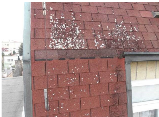
Utržená krytina na přechodové hraně mezi jednotlivými rovinami mansardové střechy.
