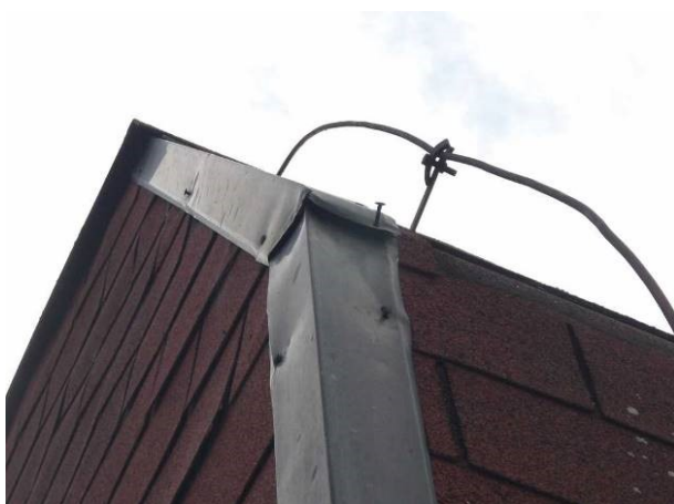
Oplechování rohu mansardové střechy. Na několika místech jsou uvolněné hřebíky.
