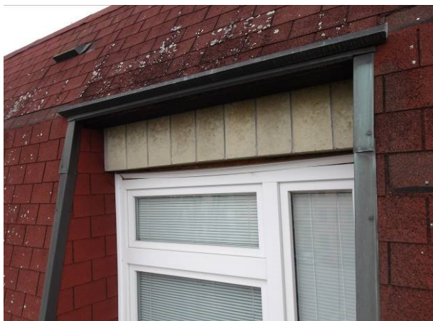
Netěsnosti kolem rámu plastového okna.
