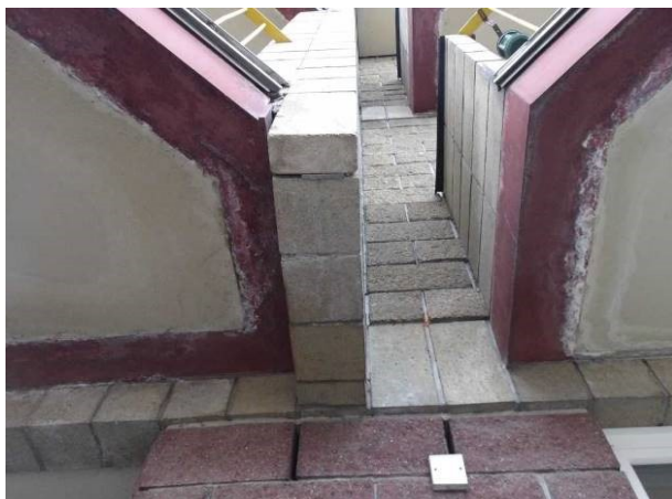
Výluhy na spodním líci balkonové desky.
