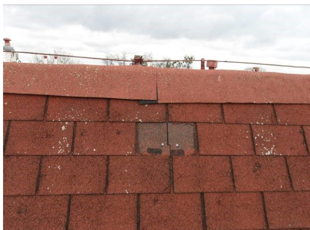
Chybějící šindel v místě spáry mezi jednotlivými šablonami.
