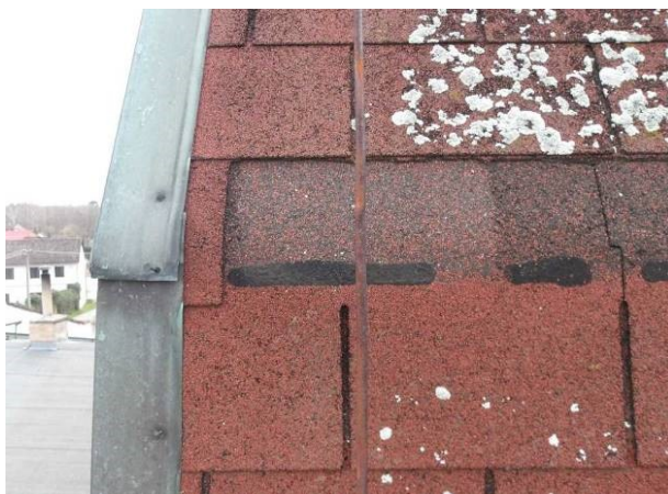
Bližší pohled na hranu mansardové střechy s utrženými šindeli.
