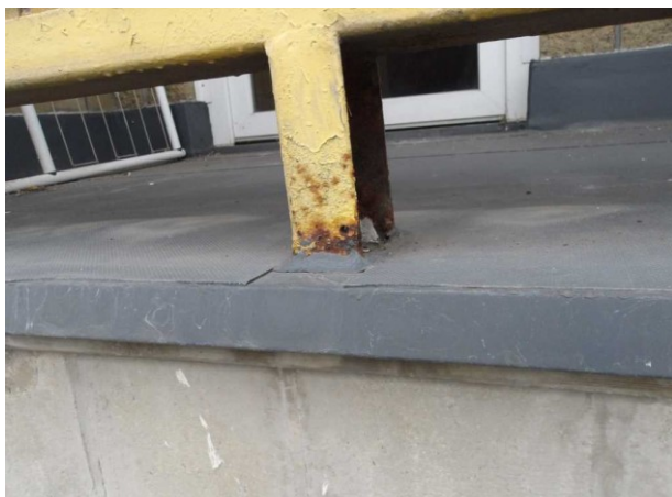
Začínající koroze některých prvků zábradlí. Hlavně sloupů ve vetknutí do desky balkonu.
