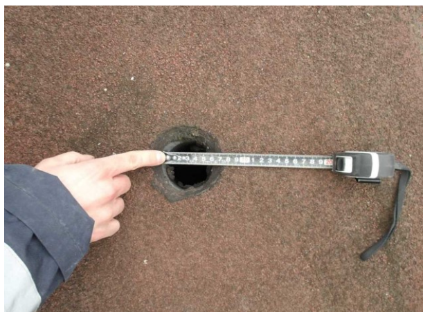
Odvodnění ploché části střechy je pomocí třech otvorů průměru 60 mm.
