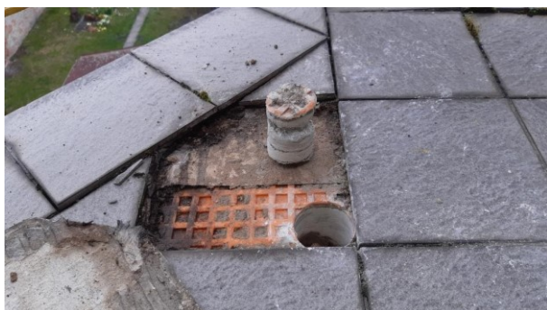
Porucha od zatékání v severní části ploché střechy.
