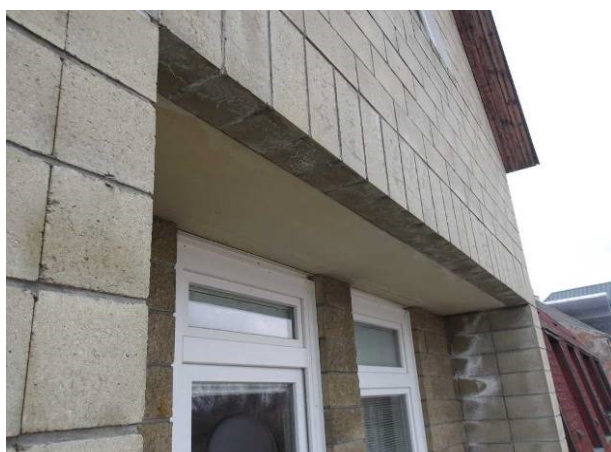
Výluhy od zatékání na spodním líci obvodového pláště v oblasti nadpraží a z boku na ostění.
