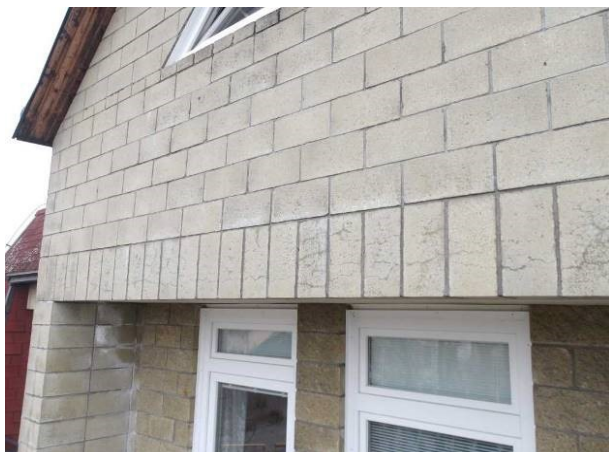
Pohled na překlad ze zděných prvků pláště. Jsou vidět vodorovně orientované trhliny. Na nenamáhaných kusech bez trhlin.
