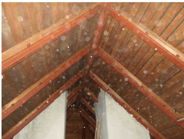
Pohled na vrcholovou vaznici v části nad schodištěm, zde bez poruch.
