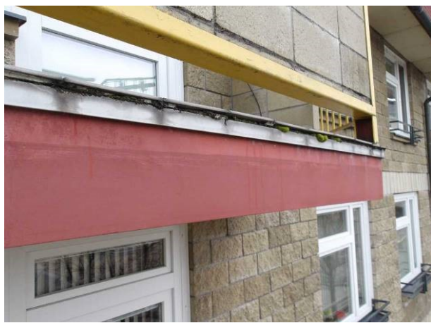
Uvolněná dlažba balkonu s mechy a drolící se ložnou maltou.
