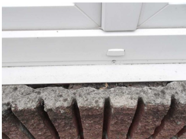
Detail na zadní straně domu na východní fasádě. Chybějící parapetní plech.
