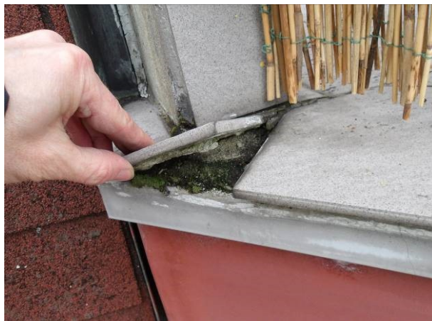
Uvolněná dlažba na balkoně.
