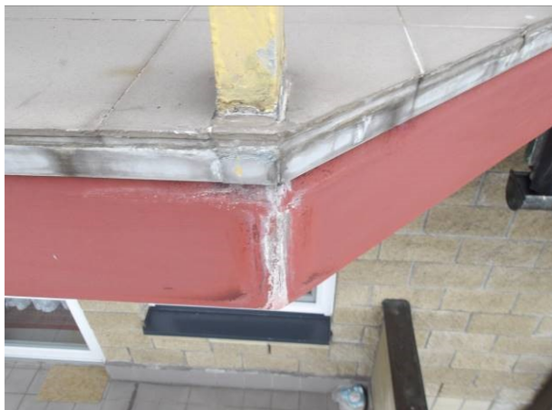
Zatékání balkonovou deskou kolem sloupku zábradlí.
