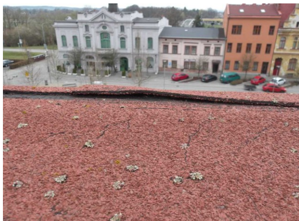
Porucha krytiny v oblasti přechodu na opačný sklon střechy.
