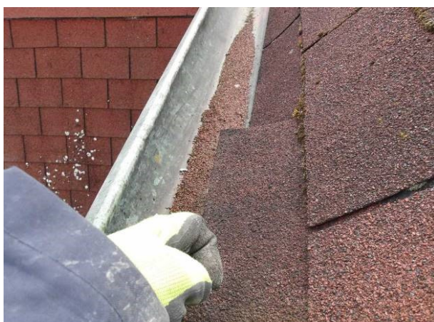
Nepřilepené dvě řady šindelů nad okapem.
