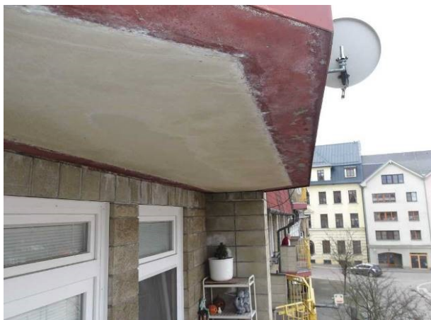
Na spodním líci balkonu jsou vidět výluhy mezi přechodem materiálů beton-ocel.
