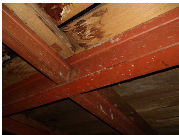
Porucha od zatékání v severní části ploché střechy.
