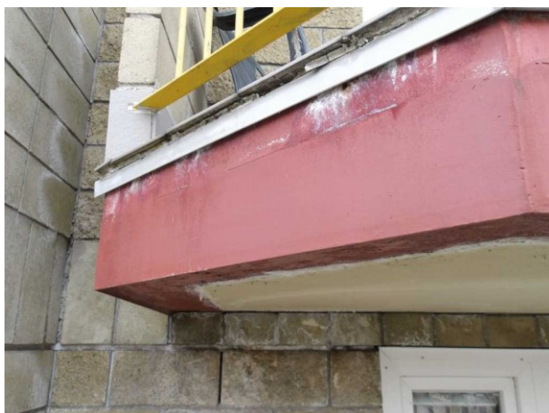
Pod dlažbou na balkonech se drží mechy, dlaždice jsou místy uvolněné. Je vidět stopy po zatékání pod okapový plech.
