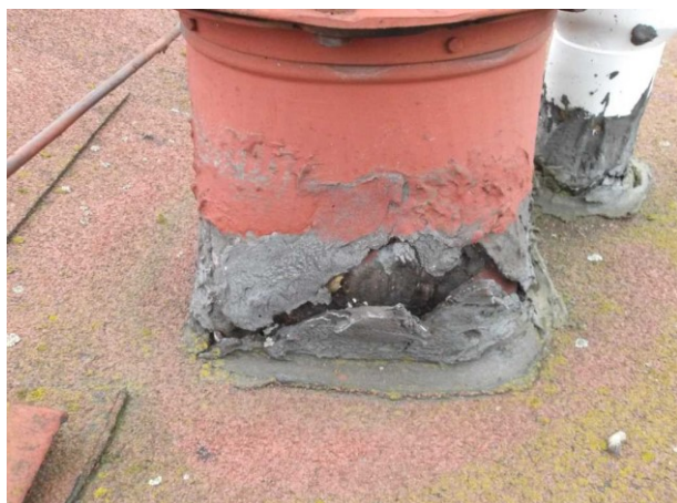
Porucha v izolaci prostupu střešním pláštěm.
