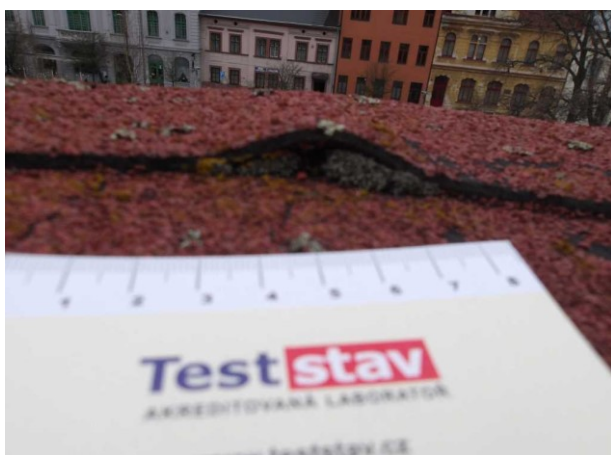
Další porucha v oblasti přechodu na opačný sklon střechy.
