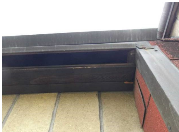
Chybějící prkno dřevěného podbití mansardy.
