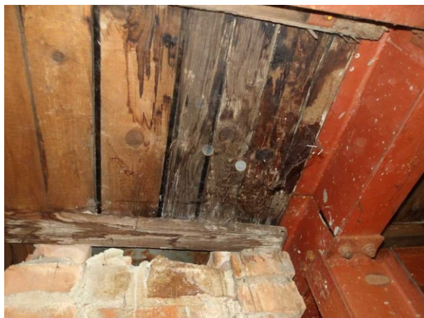
Porucha od zatékání v jižní části ploché střechy.
