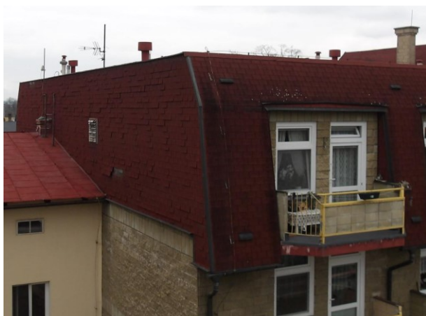
Zadní část domu. Na boční-j jižní straně je hodně odlepených šindelů. Jedná se o svislou plochu.
