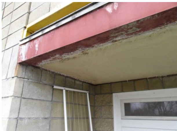
Spodní líc desky balkonu na dvorní straně domu se stejnými poruchami jako na uliční straně.
