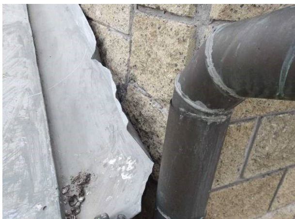
Překrytí dilatační spáry mezi sousedícími objekty. Oplechování nedoléhá ke zdi.
