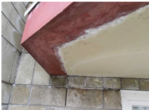
Výluhy na spodním líci balkonové desky a stopy po zatékání na vyzděný plášť pod balkonem.
