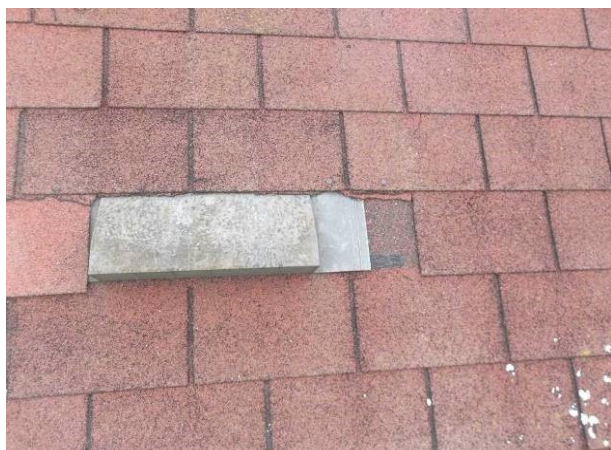
Detail odvětrávacích otvorů s poškozenými šindeli.
