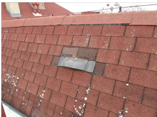
Chybějící šindele u odvětrávacího otvoru.
