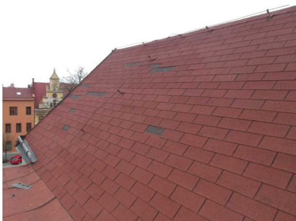
Sedlová střecha části nad schodištěm. Zde je vidět několik odlepených šindelů.
