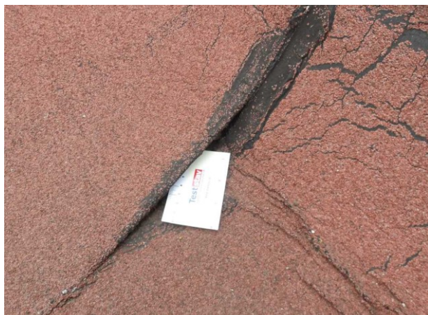
Bližší pohled na poruchu těsnosti krytiny, možná vadu natavení.
