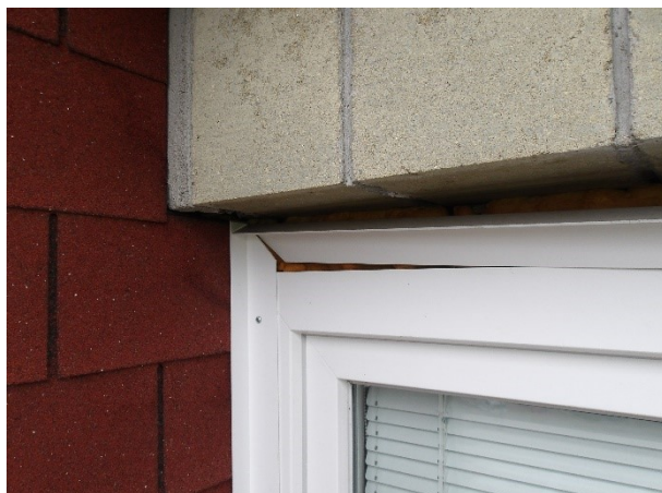
Bližší pohled na rám plastového okna. Zjevná netěsnost mezi rámem okna a plastovou horní lištou.
