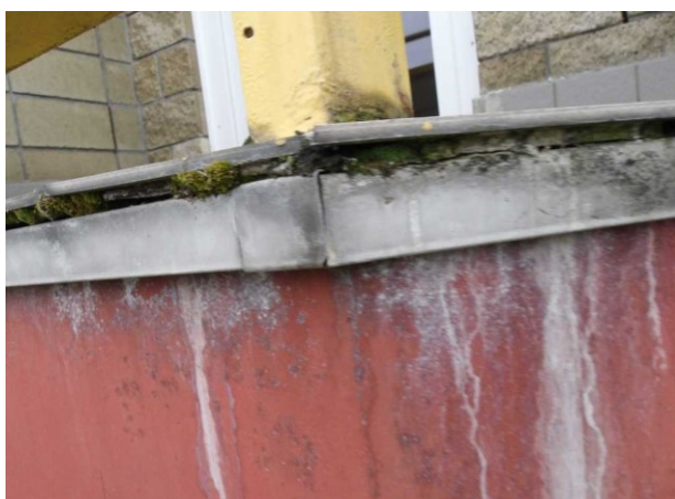
Nefunkční detail, kdy se voda dostává pod dlažbu, malta degraduje, drží se mechy a voda protéká pod okapním plechem po boční straně balkonové desky.
